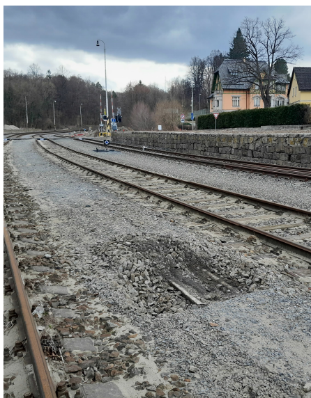
Kopaná sonda KS-9 (mezi kolejemi 3 a 1)
